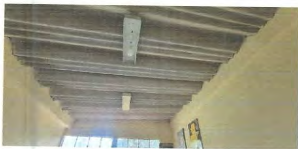
Foto 5: Se observa la falta de estructura metálica lo que genera peligro en la realización de trabajo de limpieza en el techo.
